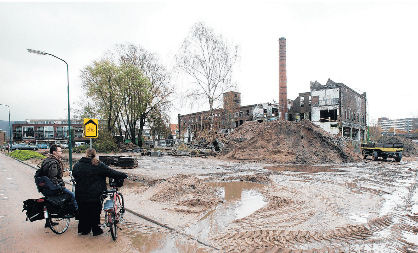
De monumentale schoorsteen van de voormalige Hollandiafabriek in Veenendaal wordt afgebroken, gerestaureerd en teruggezet. FOTO RAPHAËL DRENTH
